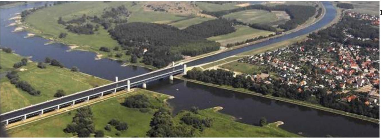
**fig. 08 - Ponte-canal na Alemanha.** Fonte: (GMF, 2011)
