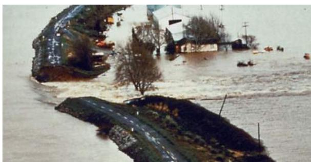
**fig. 16 - Ruptura de dique, Holanda** Fonte: (GMF, 2011)
